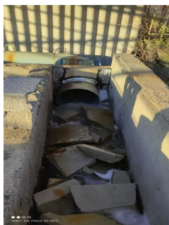
ه) ورودی کانال اصلی
