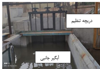
الف آبگیر جانبی و دریچه تنظیم
