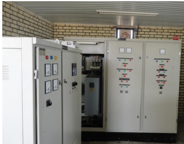
شکل ۸. نمونه ای از یک سامانه کنترلی پمپ دور متغیر در ایستگاه پمپاژ آب کشاورزی (شهرستان بيله سوار مغان)
