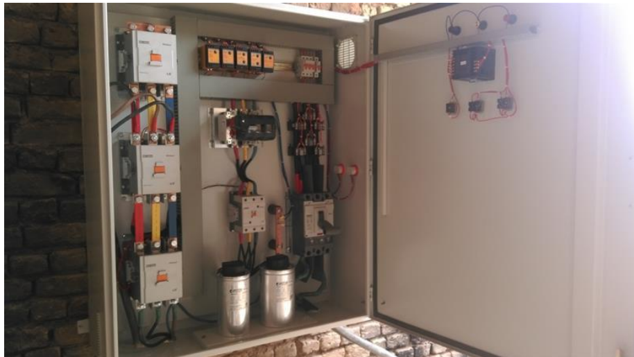
شکل ۵. نمونه‌ای از تابلو برق ایستگاه پمپاژ آب کشاورزی تجهیز شده به بانک خازن
