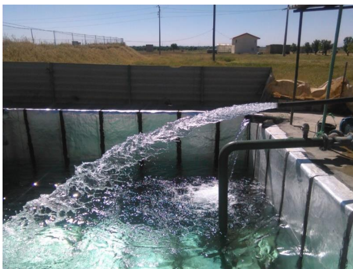
شکل ۳. نمونه ای از تلفات انرژی در ایستگاه پمپاژ آب کشاورزی به دلیل شیوه کنترل جریان در محل ایستگاه پمپاژ
