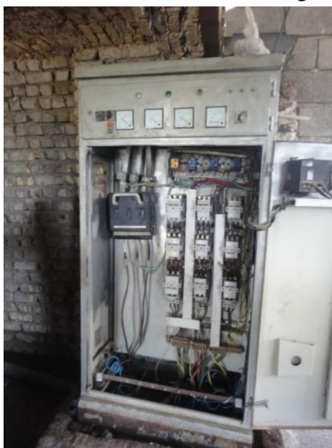
شکل ۴. نمونه‌ای از راه‌اندازی ایستگاه پمپاژ به روش ستاره - مثلث
