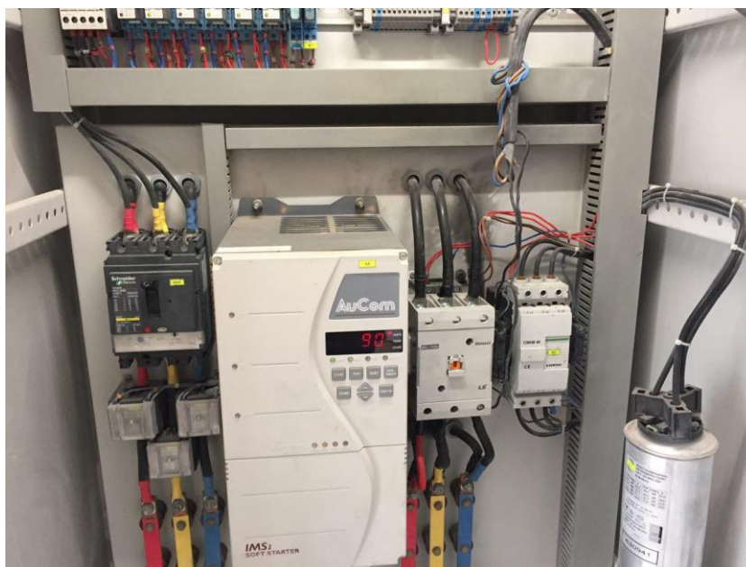
شکل ۶. نمایی از تابلو برق ایستگاه پمپاژ آب کشاورزی تجهیز شده به راه انداز نرم
