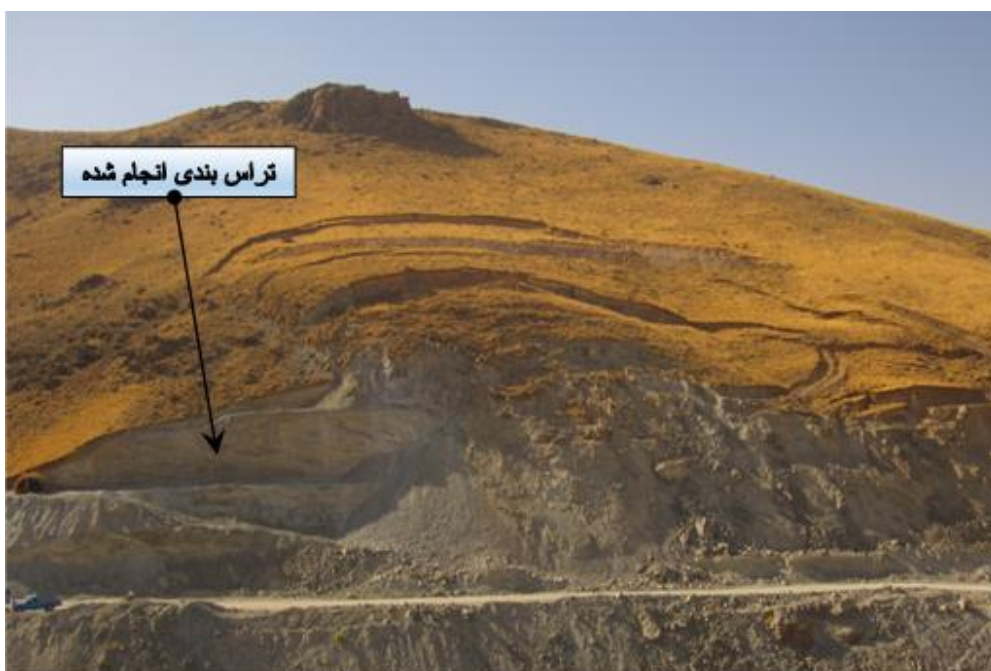
شکل ۲. وضعیت لغزش در شیروانی
